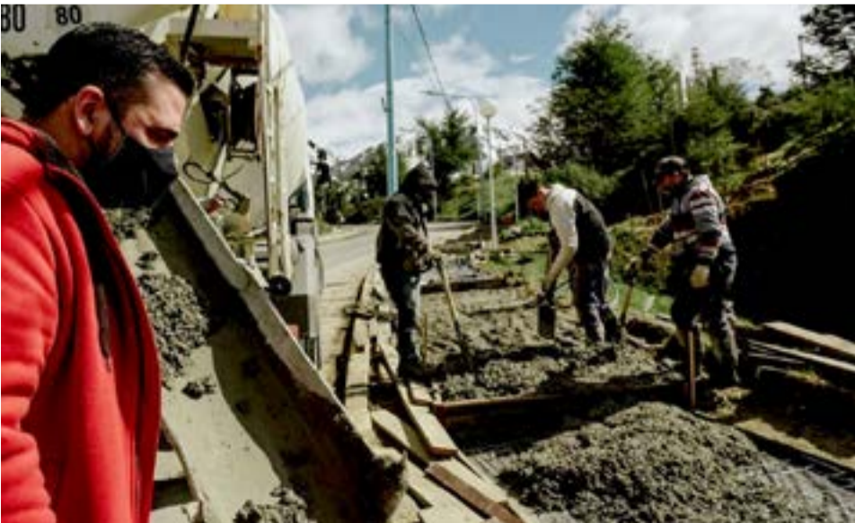
Durante la mañana del sábado el intendente Walter Vuoto recorrió distintos trabajos que se vienen realizando en la ciudad capital.
