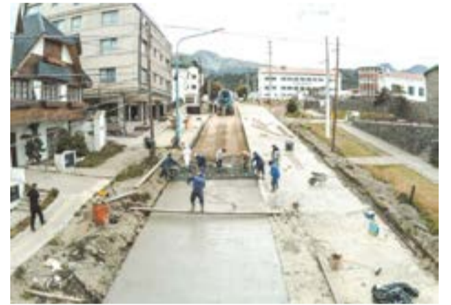
Continúa la repavimentación de la calle Yaganes, tras los trabajos de readecuación de la red pluvial y cloacal que permitieron llegar a la instancia de colocación de hormigón, en el marco del plan de obras trazado por la Municipalidad de Ushuaia.
