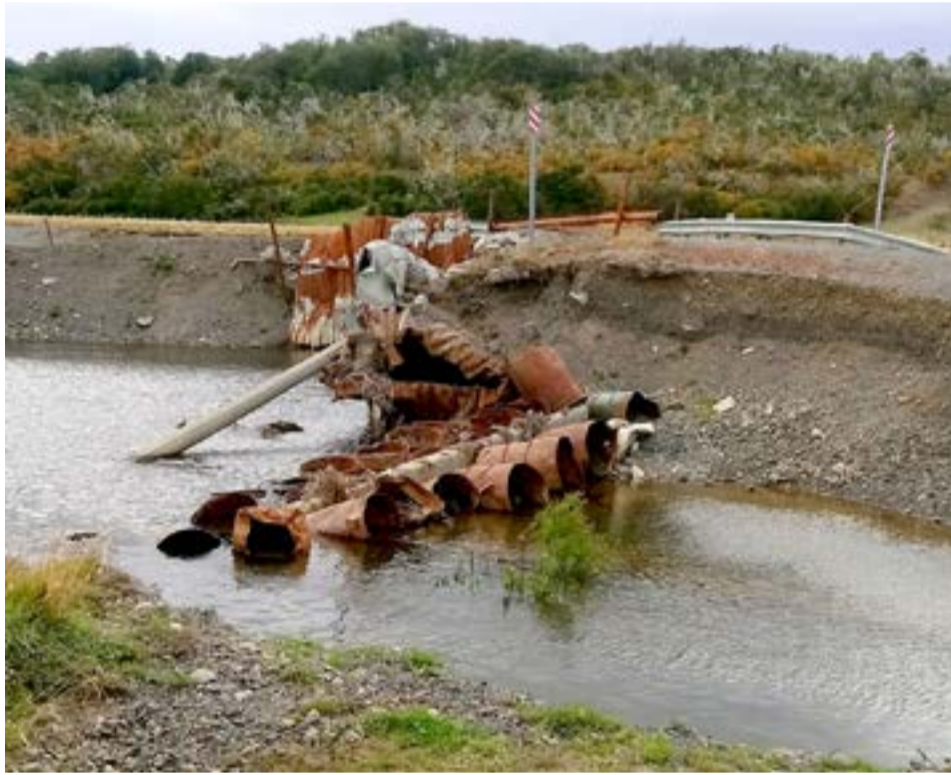
También se avanza con el puente nuevo de Radman, que ya está en la provincia, y se gestiona el financiamiento para la obra civil, que ronda los 60 millones.
