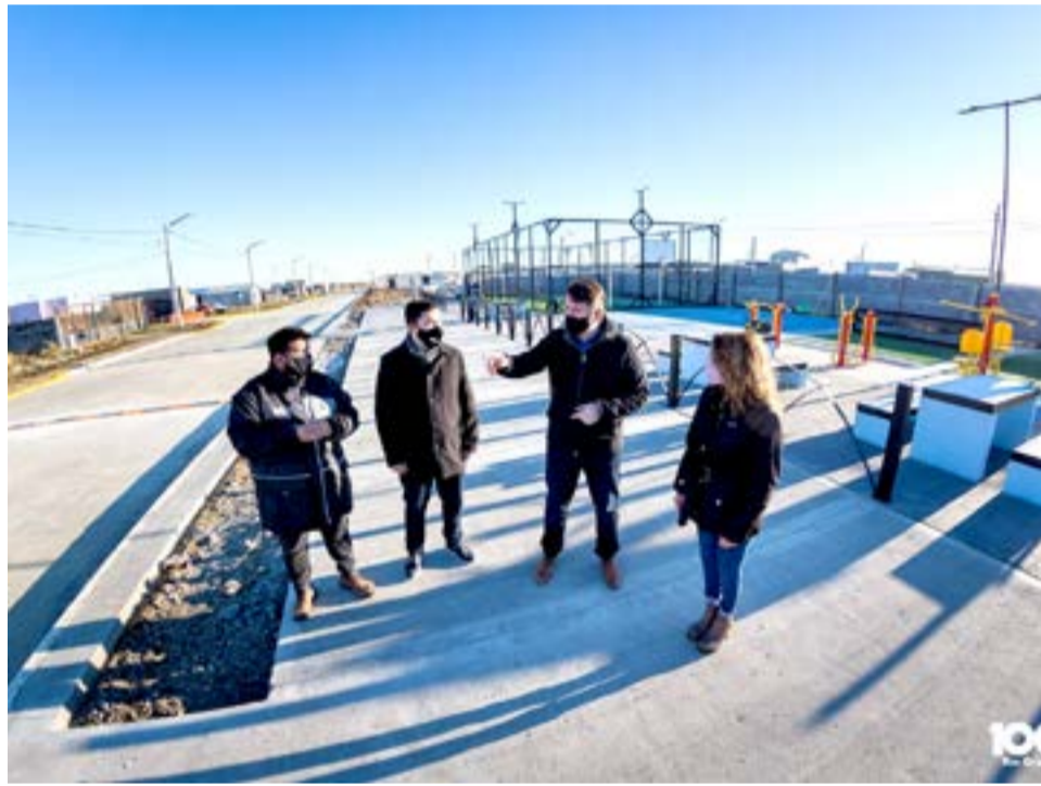
Este jueves por la tarde, el Intendente Martín Pérez dejó formalmente habilitada la obra de pavimentación que se llevó a cabo en la calle Santísima Trinidad, en el barrio Batalla de Georgias.
