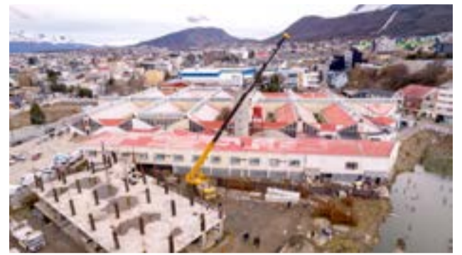
El Ministerio de Obras y Servicios Públicos de la Provincia, comenzó los trabajos preliminares, para reponer la cubierta de techo de la nave siniestrada del Hospital Regional Ushuaia en el mes de julio.
