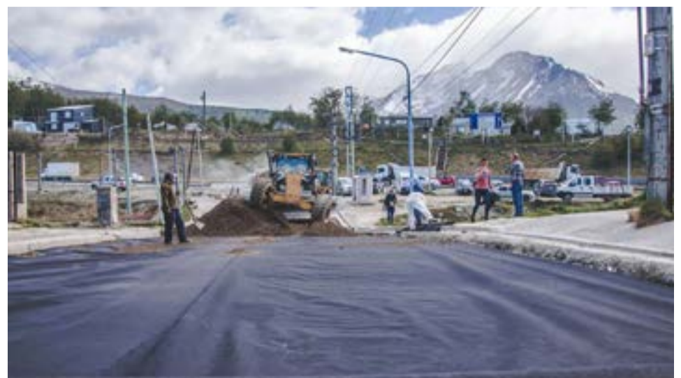
Muñiz Siccardi destacó que “ya se están realizando las últimas bases para la colocación de columnas en la calle principal de la urbanización y nos encontramos en la etapa final del tendido de cableado aéreo en todos los sectores” indicó la funcionaria municipal.
