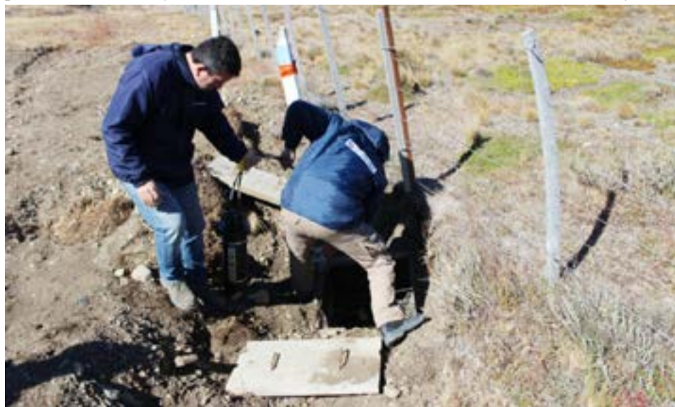
Esta conexión se realizó en Estancia Cullen y participó el equipo de empalmadores de la contratista de ARSAT, la firma COIVALSA liderado por Javier Viloutta.
