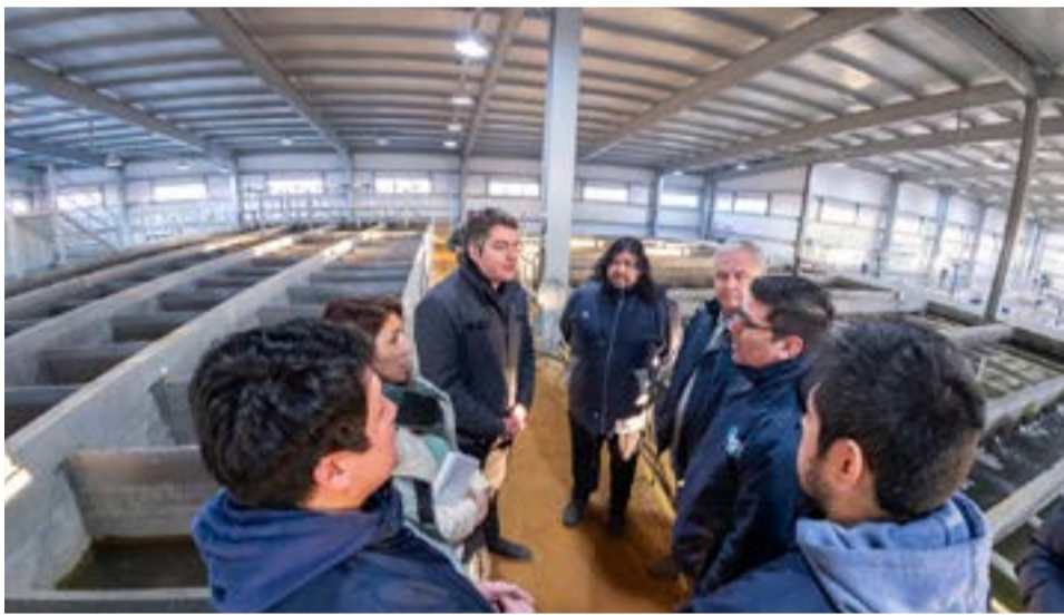
La secretaria de Planificación, Inversión y Servicios Públicos, arquitecta Silvina Mónaco, refirió que la obra “consistió en la readecuación de la Estación Reguladora de Presión, adaptándola a las necesidades de las dos Plantas Potabilizadoras con las que cuenta Río Grande”.
