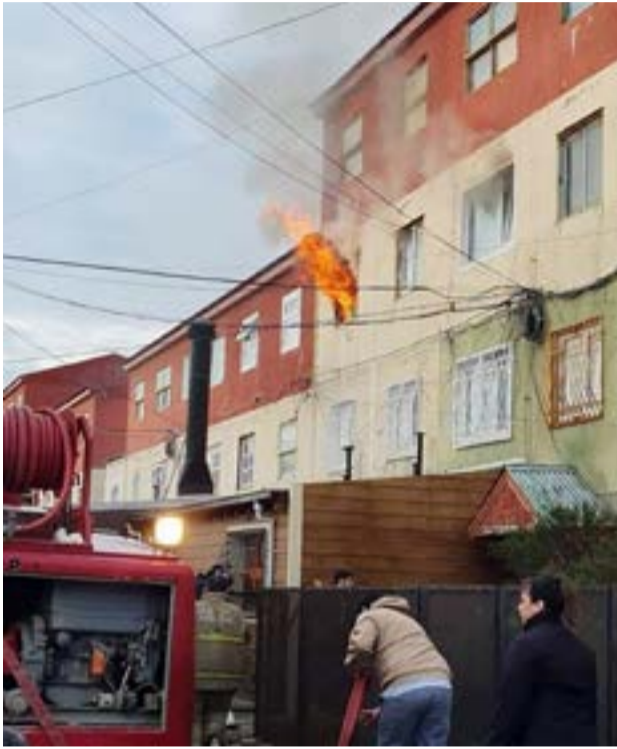
Incendio en un departamento de Chacra II pone en jaque la seguridad y falta de escaleras de emergencia.
