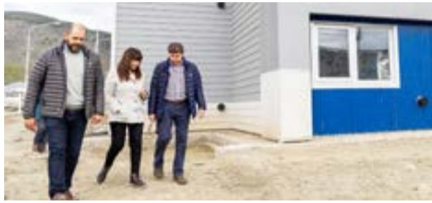
El gobernador Gustavo Melella junto al ministro jefe de Gabinete, Agustín Tita y la presidenta del IPVyH, Laura Montes, recorrieron la obra de las 64 Viviendas “Hanuxa” que se ejecutan en el barrio Río Pipo de Ushuaia.
