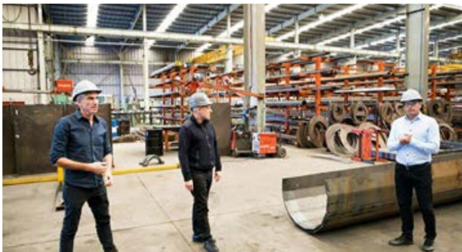
Una empresa en Buenos Aires está construyendo las nueve pilonas de la nueva telecabina del Glaciar Martial.
