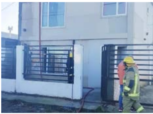
Principio de incendio sobre una vivienda fue controlado rápidamente.
