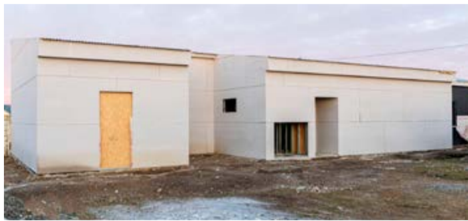
"El nuevo edificio de Zoonosis en Zona Sur estará finalizando a fin de año", estimó Gonzalo Ferro.
