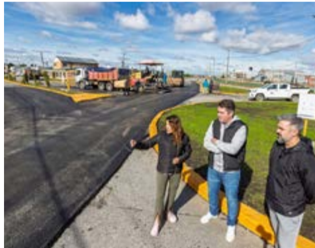
El intendente Martín Perez supervisó la obra de recapado asfáltico de la rotonda de O'Higgins y Pacheco. Estuvo acompañado por la secretaria de Obras Públicas, Arq. Silvina Mónaco.
