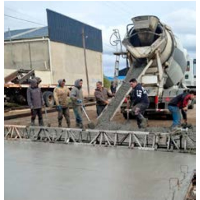
Obra de pavimentación con fondos del FAMP de 12.000 millones de pesos, no reintegrables.
