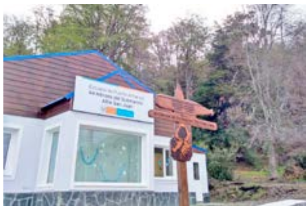
La directora provincial de Energías Renovables, Ariana Pérez, confirmó la puesta en funcionamiento de un sistema de energía solar en la escuela de Puerto Almanza, en lo que definió como un avance concreto en materia de transición energética en la provincia.
