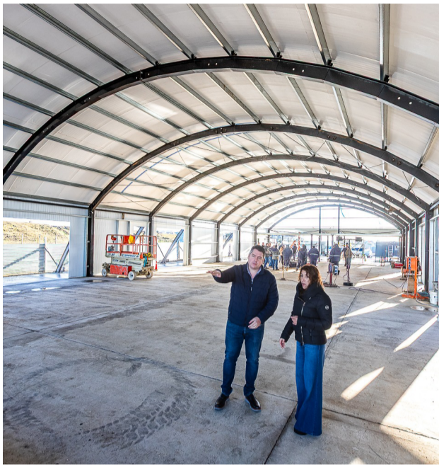
El intendente Martín Pérez visitó la obra del edificio permanente de la Carpa de la Dignidad para supervisar el avance de los trabajos que se desarrollan en este espacio emblemático que estará destinado a fortalecer la memoria colectiva, la identidad fueguina y el reconocimiento a los héroes de Malvinas.
