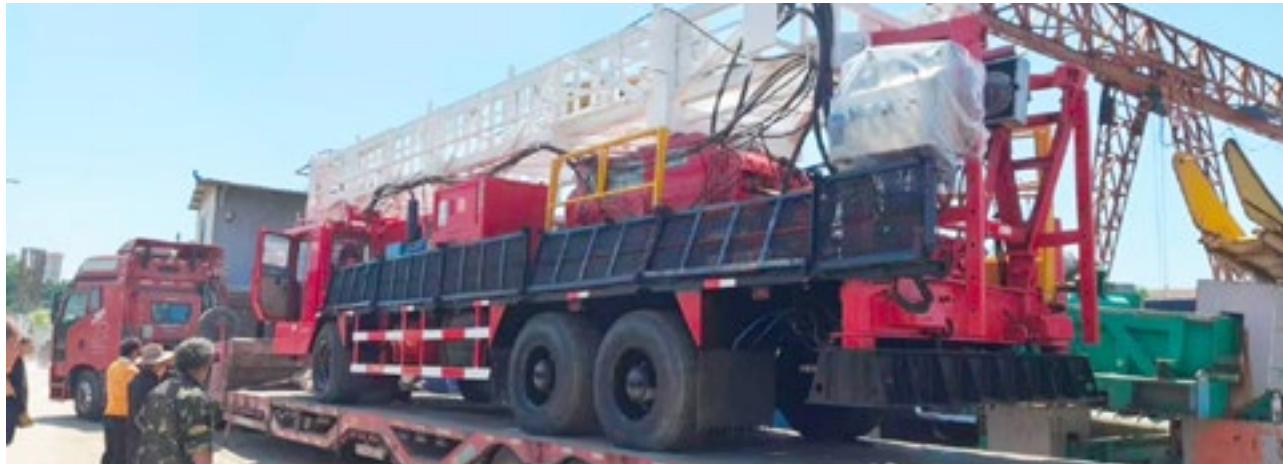
El presidente de Terra Ignis Energía S.A., Maximiliano D'Alessio, destacó la llegada a Ushuaia del buque Shipping Ji Xiang, que transporta la turbina y los distintos componentes destinados a la construcción de la nueva central de generación eléctrica, y aseguró que el acontecimiento representa uno de los principales hitos alcanzados desde la creación de la empresa provincial.
