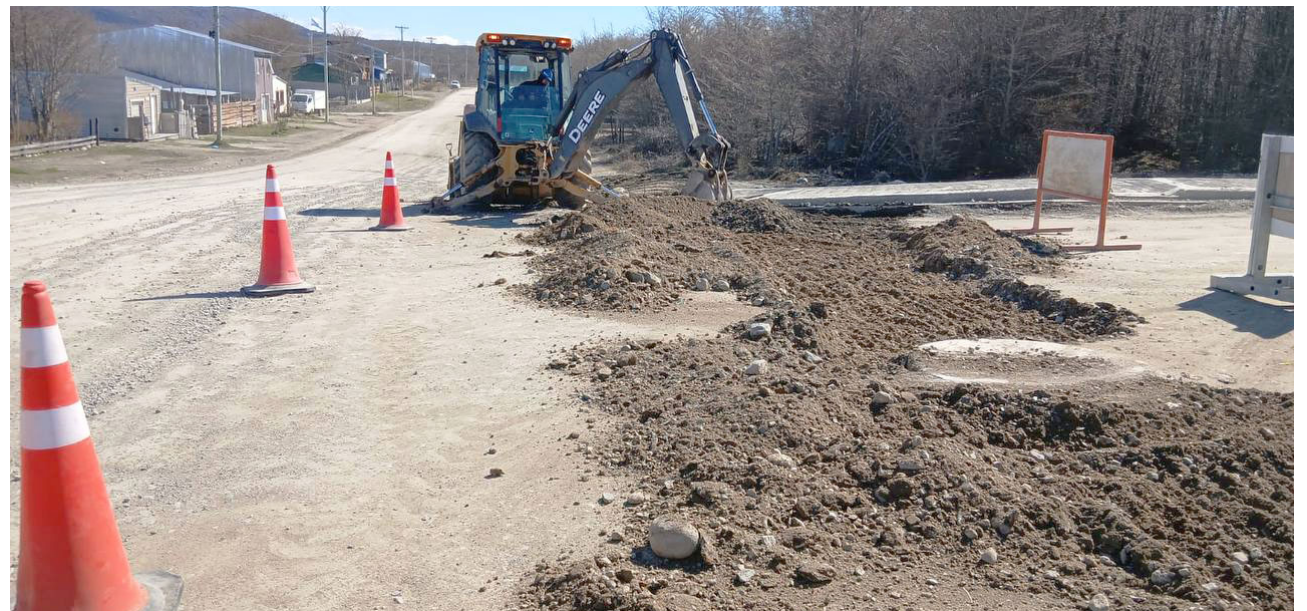
La Dirección de Tránsito y Seguridad Vial del Municipio de Tolhuin informa a la comunidad que se realizarán cortes totales de circulación en calle Seriot, debido a trabajos de construcción de badenes cementados.
